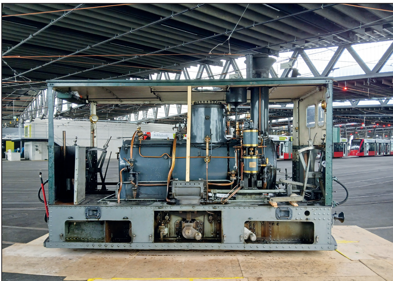
Das Triebwerk des Dampftrams ist während der Sanierung im Depot Bolligenstrasse komplett ausgebaut.
